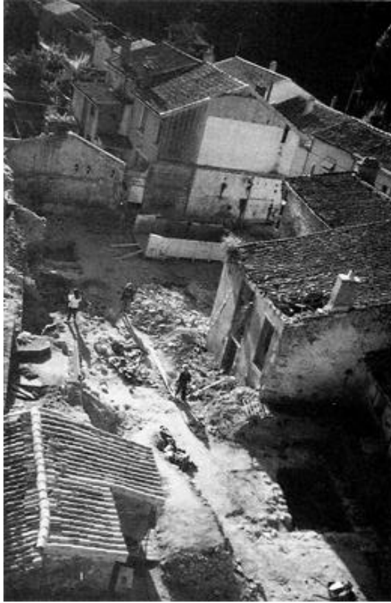
Fouille en 1989 sur le site de la future M.C.P.
