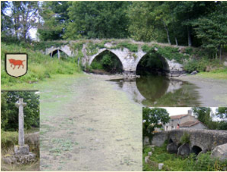
La croix, les ponts et le moulin de Sunay, ainsi que les armoiries de Barthélemy Boidin (vers 1680).
